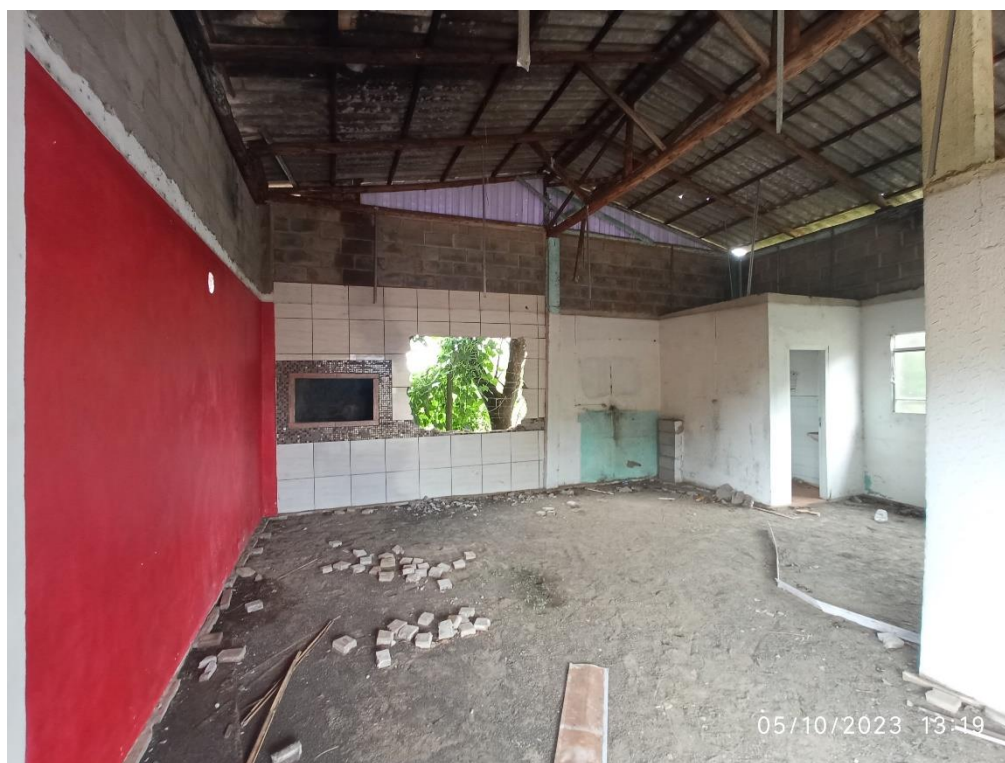
Figura 02: Vista interior edificação barracão.
