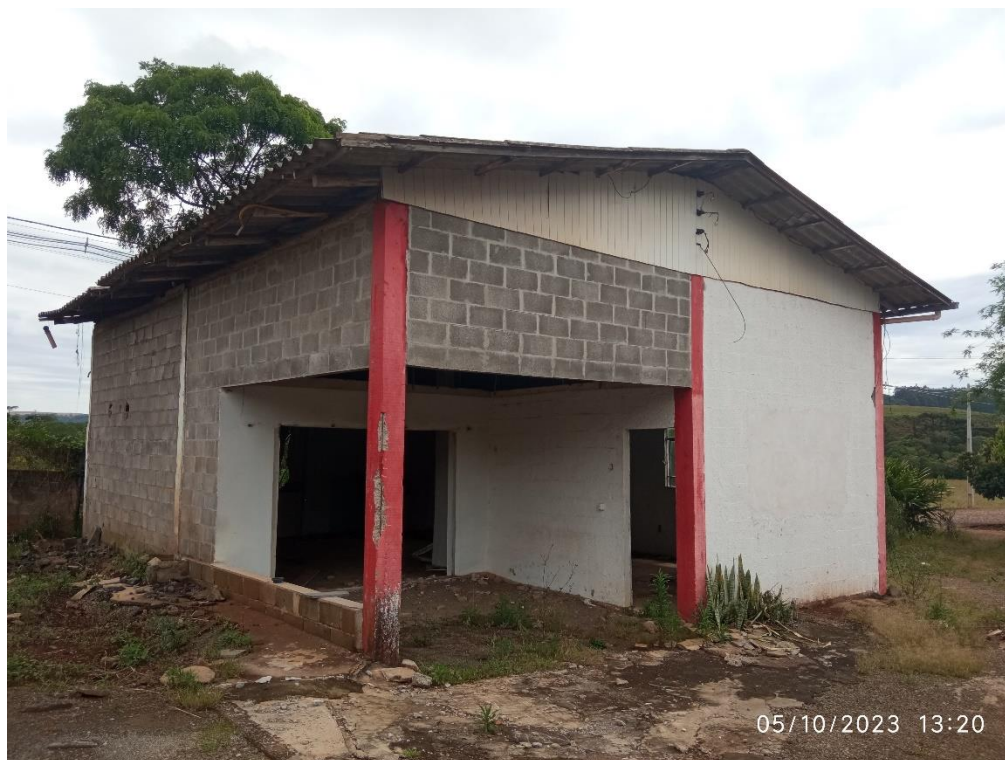
Figura 01: Vista edificação barracão.
