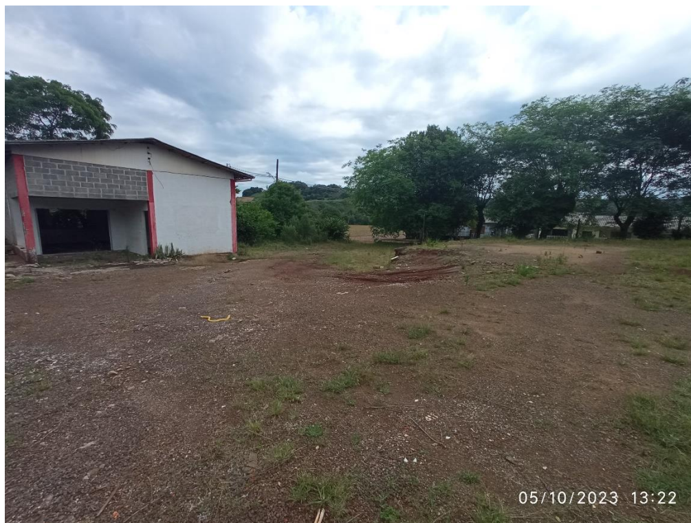
Figura 05: Vista interior lote..
